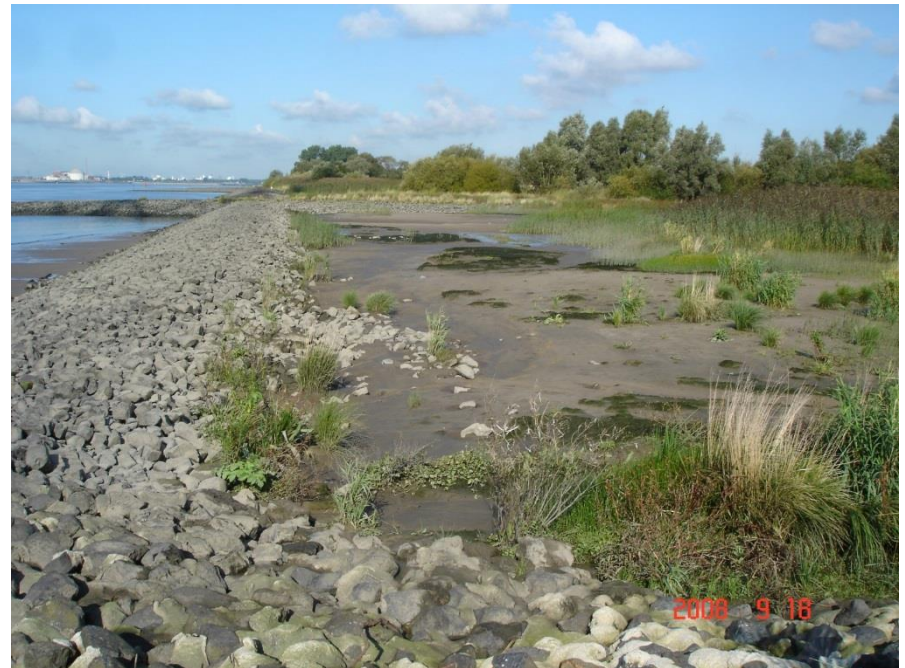
Beispiel: Uferschutzrückbau am Juelssand Erweiterung der Wasserwechselzone hinter der Ufersicherung
